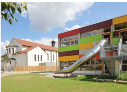
Das fertige Kinderhaus mit Rettungsrutsche und der Friedenskirche im Hintergrund
