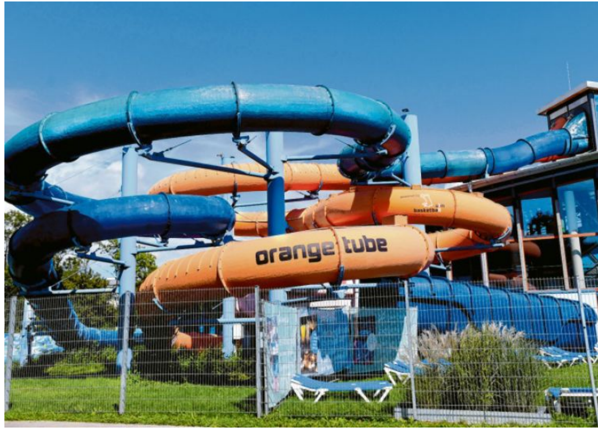
Die Farbe ist verblasst – doch das ist das geringste Problem: Der Kunststoff der Donaubaad-Rutschen geht kaputt, Kanten treten hervor und Wasser tropft herunter.
